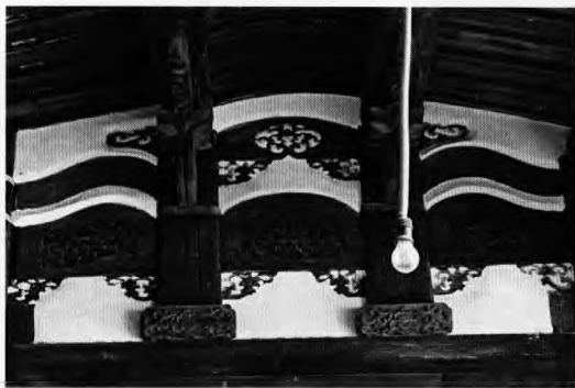
前廊西侧门梁架细部
