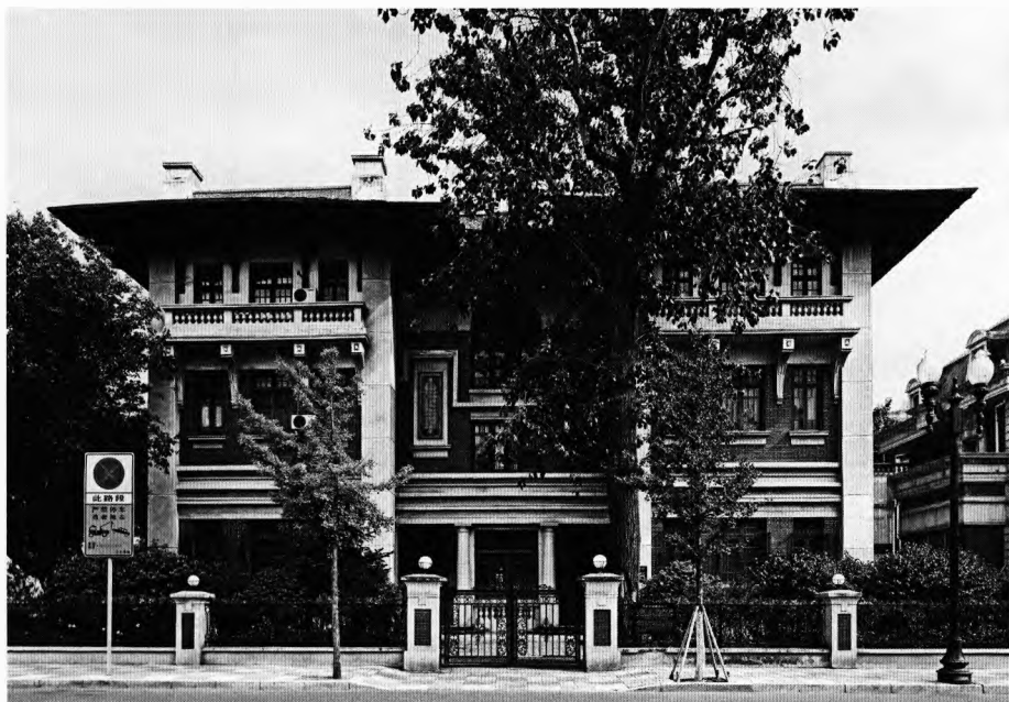
北楼沿马场道北立面
