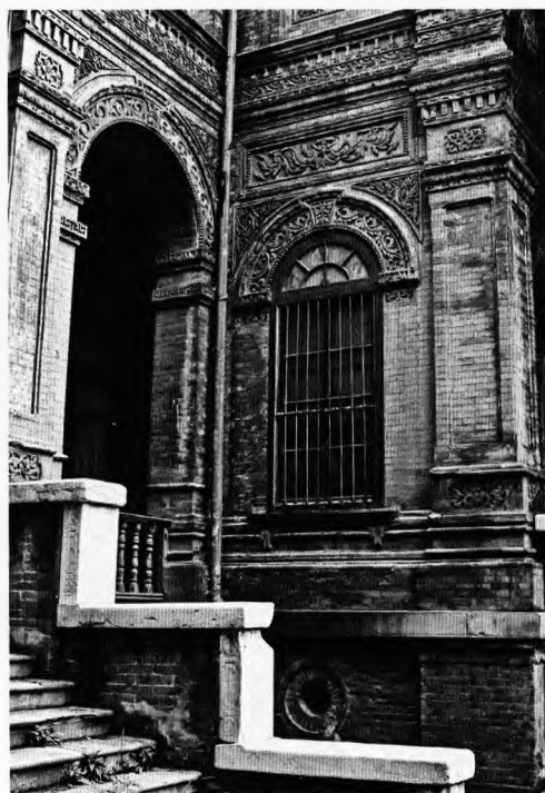
铁狮子胡同建筑现状之二
