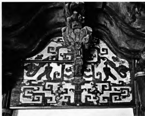
侧座后庭（东楼之南侧房二层后廊梁架）
