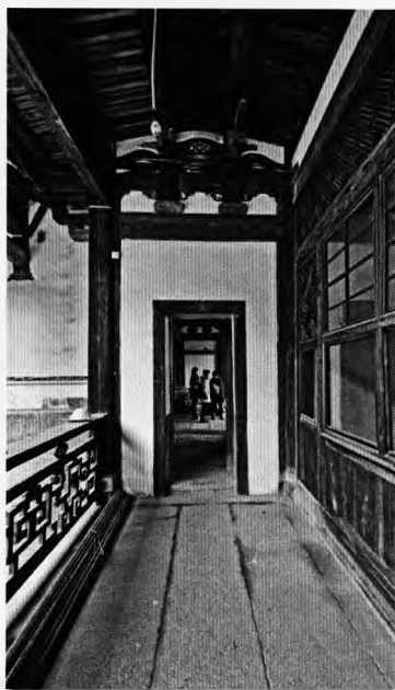
前廊东侧门（通往侧座花厅）
