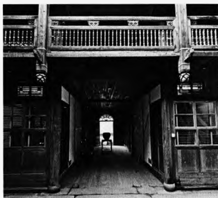
侧座后庭（东楼之背面）
