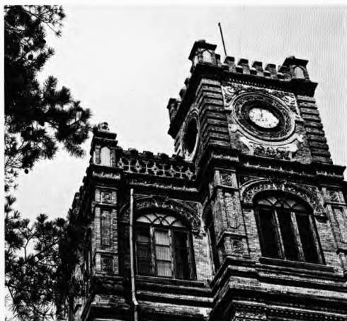
铁狮子胡同建筑现状之一
