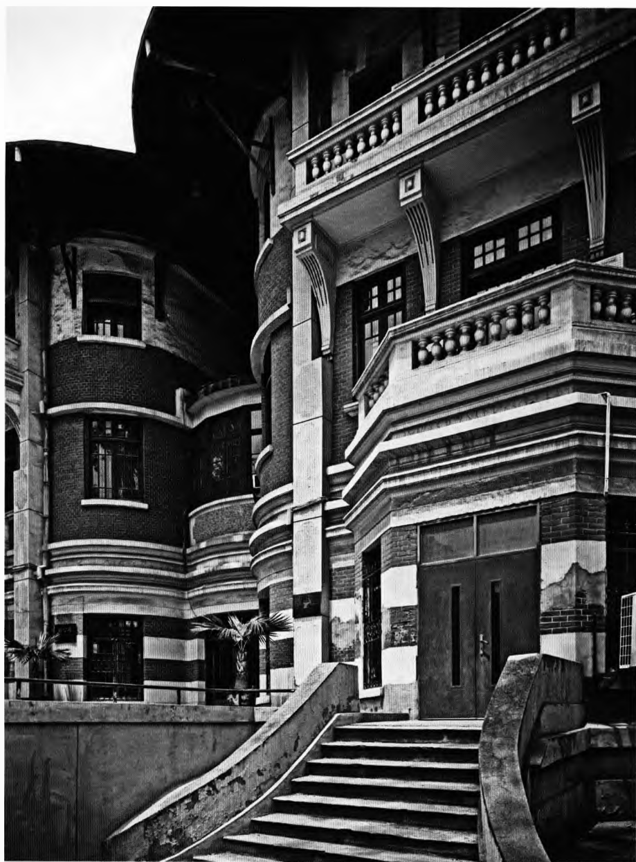
北楼南立面入口大台阶
