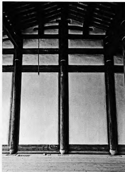
二堂室内梁架
